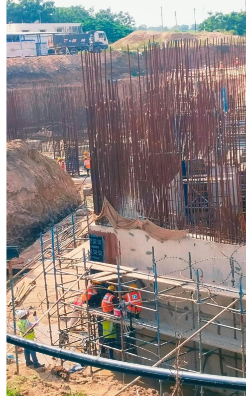
వాగులో బహుళ అంతస్తుల భవన నిర్మాణం
